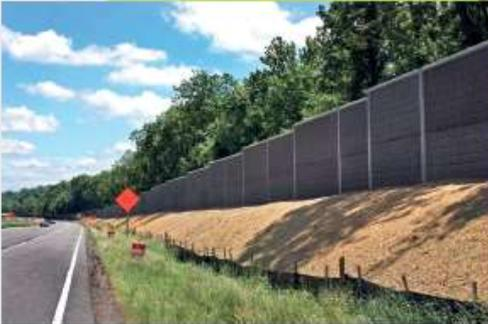
Barreira de isolamento acústico e poluição, no exemplo, associada a sistema de estabilização de taludes e restauração ambiental - Canadá
