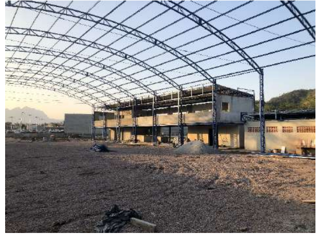
Edificação em construção: Arquibancada, churrasqueira e vestiários
