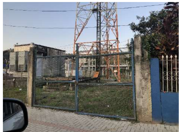
Vista do imóvel da torre de telecomunicações
