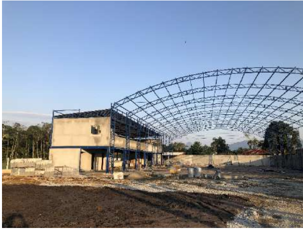
Edificação em construção: Quadra de futebol society
