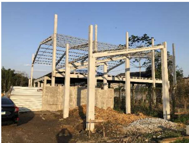
Edificação em construção: Entrada/Bilheteria
