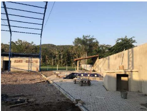
Edificação em construção: Piscina
