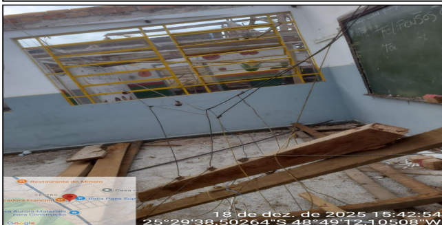
8 | REMOÇÃO DE TELHAS E ESTRUTURAS
