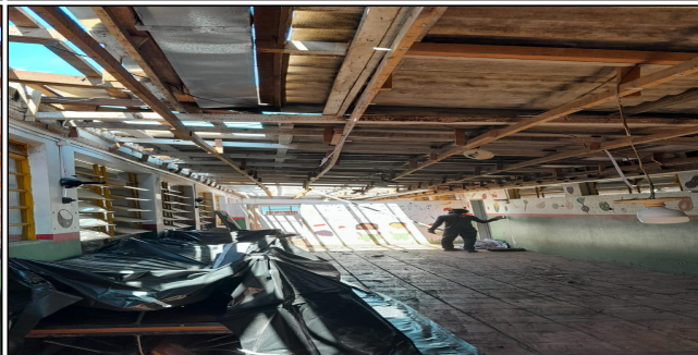
7 | REMOÇÃO DE TELHAS E ESTRUTURAS
