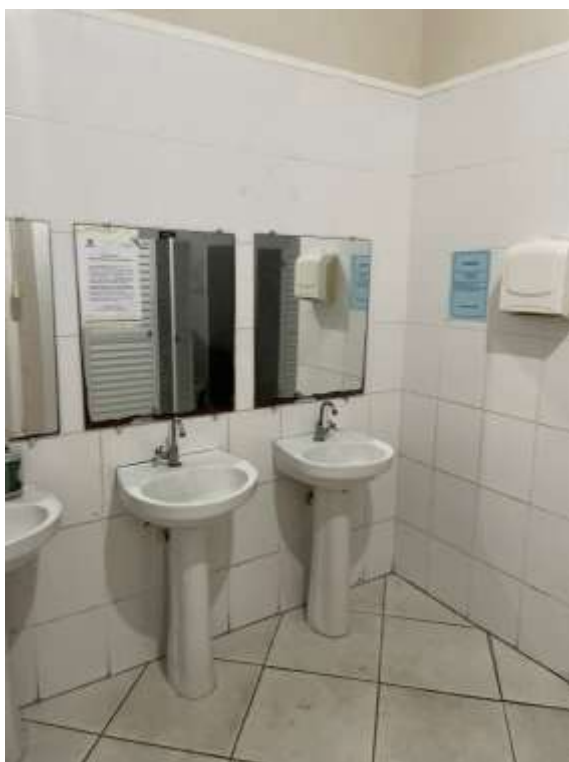
IMAGEM 14 – BANHEIRO MASCULINO – LADO INTERNO 2
