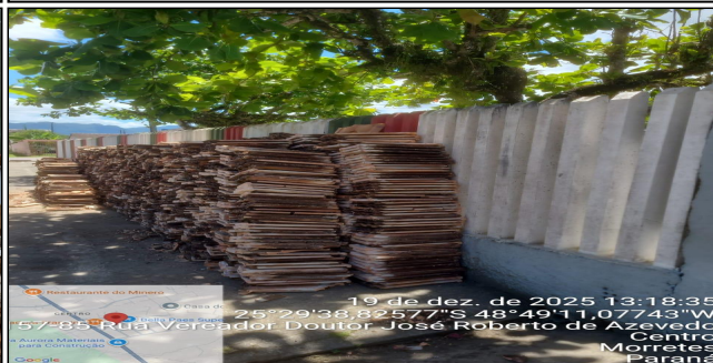
9 | REMOÇÃO DE TELHAS E ESTRUTURAS
