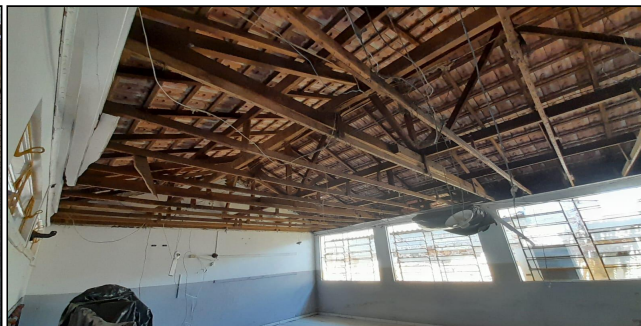
5 | REMOÇÃO DE TELHAS E ESTRUTURAS
