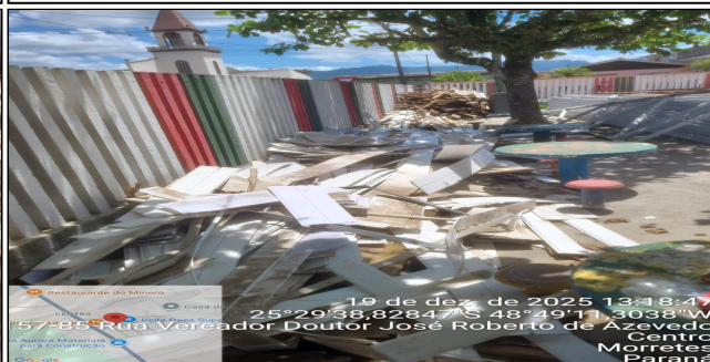
11 | REMOÇÃO DE TELHAS E ESTRUTURAS
