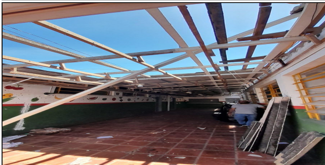
6 | REMOÇÃO DE TELHAS E ESTRUTURAS
