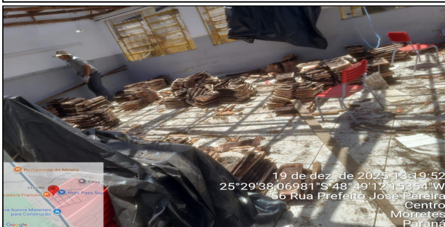
10 | REMOÇÃO DE TELHAS E ESTRUTURAS
