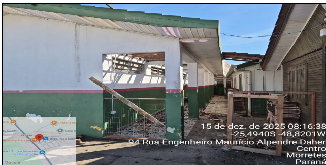
4 | REMOÇÃO DE TELHAS E ESTRUTURAS
